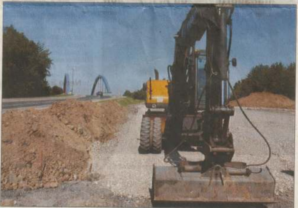
Die Bauarbeiten für den Ausweichts- und Wanderparkplatz an der neuen Kanalbrücke in Werne sind jetzt gestartet worden. (Foto: Ulrich Bonke)
