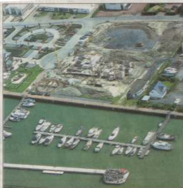
Die beta-Baustelle am Hafen in Rünthe. • Foto: Rother
