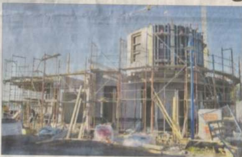
Die Arbeiten an den 35 Eigentumswohnungen im Hafen gehen weiter; die Kosten für die Handwerker auch. Doch Einnahmen hat die beta GmbH immer noch nicht. (Bild: Iris-Medien)
