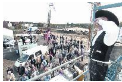
Zimmermannsmeister Frank Durach feierte mit den Besuchern Richtfest des ersten Hauses. Foto: Hennes
