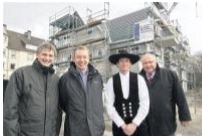
Landrat Michael Makiolla, Beta-Chef Dirk Salewski, Zimmermeister Frank Durach und Bürgermeister Rother auf der Baustelle. Foto: Hennes
