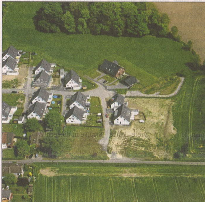
Die Parkfläche wird zurzeit hinter dem Baugebiet (hier rechts im Bild) abgelegt. ■ Foto: Blossey
