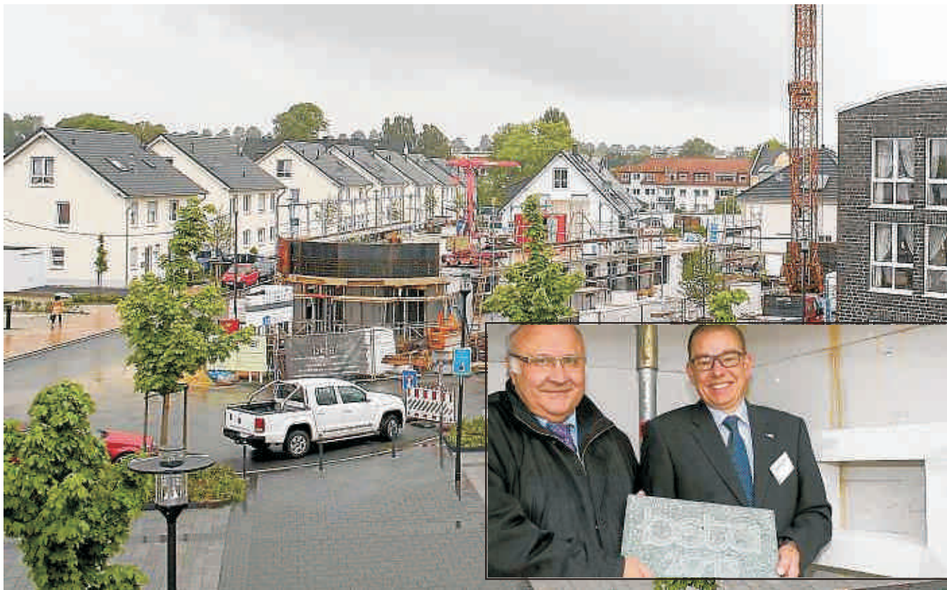
Grundsteinlegungen im Wohngebiet Neue Caroline sind für Dirk Salewski fast schon Tradition. Der beta-Chef nahm gestern gemeinsam mit Bürgermeister Jenz Rother (kleines Bild) die dritte seit 2006 vor. Das Haus am Quartiersplatz (großes Bild) schließt die letzte große Lücke. Jetzt gibt es nur noch einige wenige freie Grundstücke.
