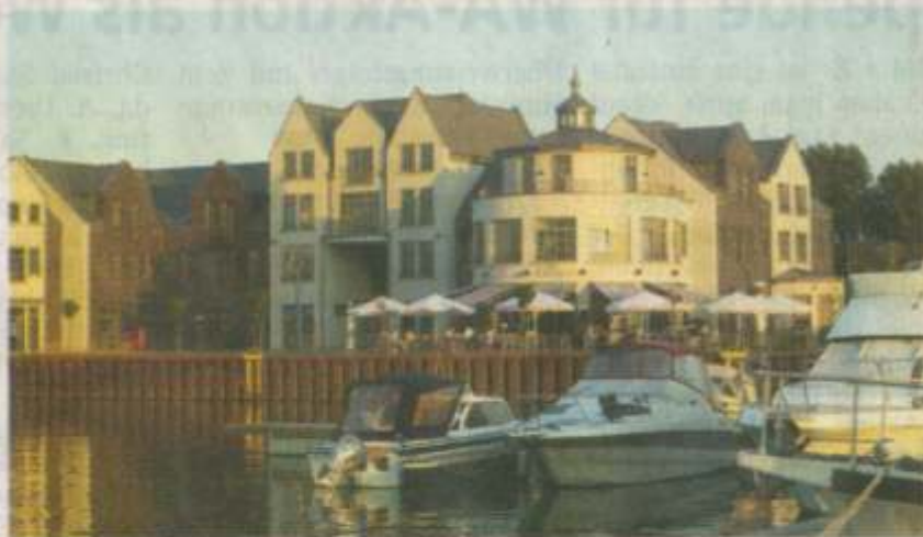
Bereits beim Bau des Hauptsitzes der beta und des Restaurants Neumanns Nautilus wurde der Stil der Hamburger Speicherstadt aufgegriffen. Im gleichen Stil sollen daneben zwei neue Gebäude entstehen.
