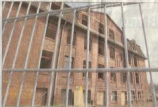
Der Abriss hat begonnen: die Fenster aus dem Laborgebäude sind schon weitgehend entfernt. (Bild: Henryk Brock)
