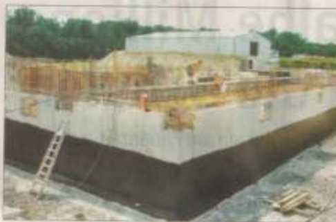
Die Bauarbeiten in der Marina Rünthe gehen voran.
