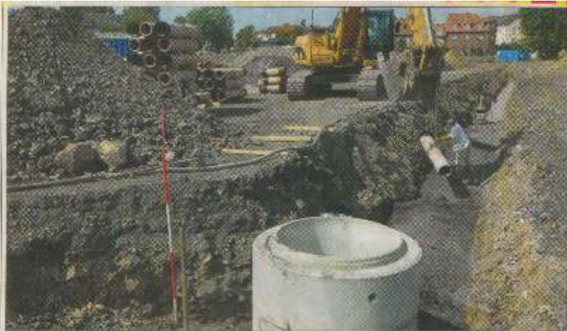
Die ersten Entwässerungsleitungen sind verlegt. Die Erschließung des Komplexes Neue Caroline auf der Marquiden, 70, ist in Abstimmung durch die Stadt Greifswald mit den zuständigen Behörden im Gange. • Foto: rüchtes
