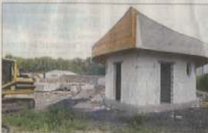
Im Rohbau bereits fertig: Das neue Sanitärgebäude der Marina Rünthe - natürlich in Form eines Schiffes. (Fotos (3): Iris-Medien)
