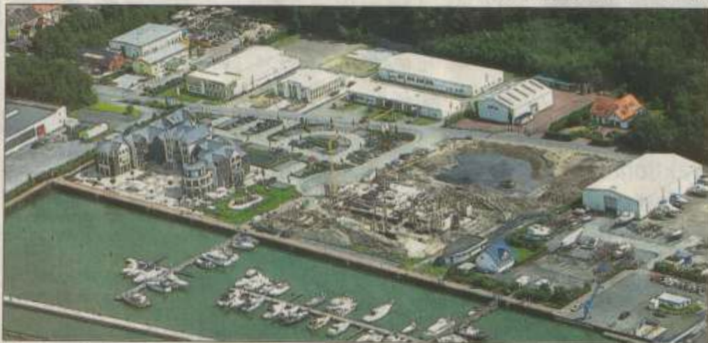
Die Baustelle am künftigen Hafenplatz in Rünthe. • Foto: Rother
